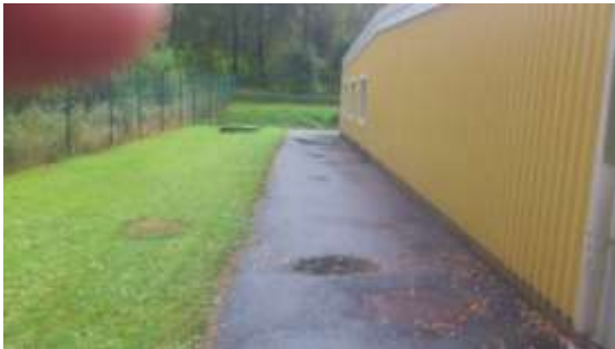
Inkommande ledning med nödavloppsbrunn
