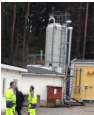
Tunnslamlager och tjockslamsilo Mekanisk slamförtjockare
