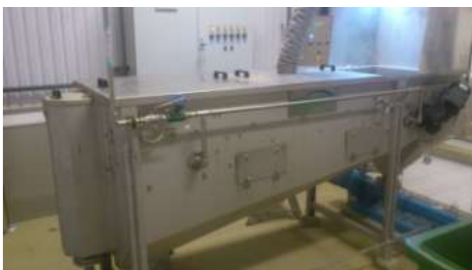
Tunnslamlager och tjockslamsilo Mekanisk slamförtjockare
